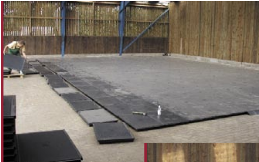
Instalación de HIT-CAMA BLANDA PLUS
