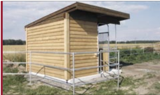
Tuulenpuoleisten seinien on hyvä olla tiiviitä
