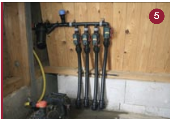
Vier Wasserkreisläufe für die 800 m 2 Fläche
