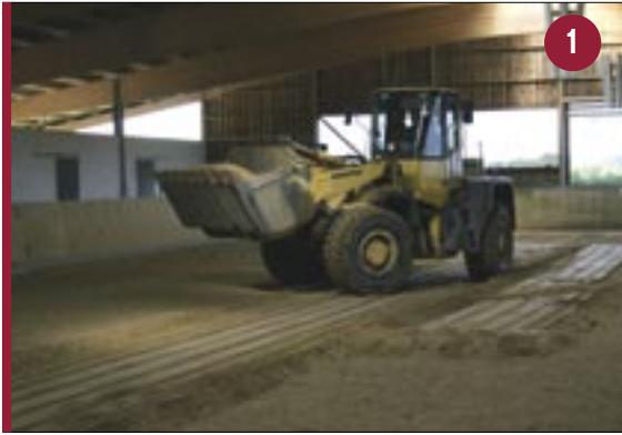
Entfernen der vorhandenen Tretschicht
