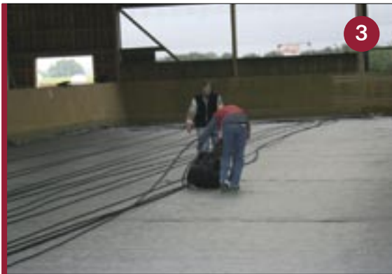
Abrollen der PE-Rohre
