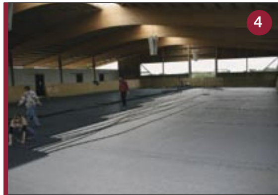
Verlegen HIT-DRAINGRID® H 55.0
